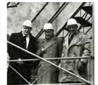
Robert Bordaz, Paul Sacher und Pierre Boulez (v.l. n.r.) 1975 auf der Baustelle des IRCAM/Centre Pompidou
